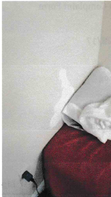
Fig. 5 – Bedroom (wall patch)
